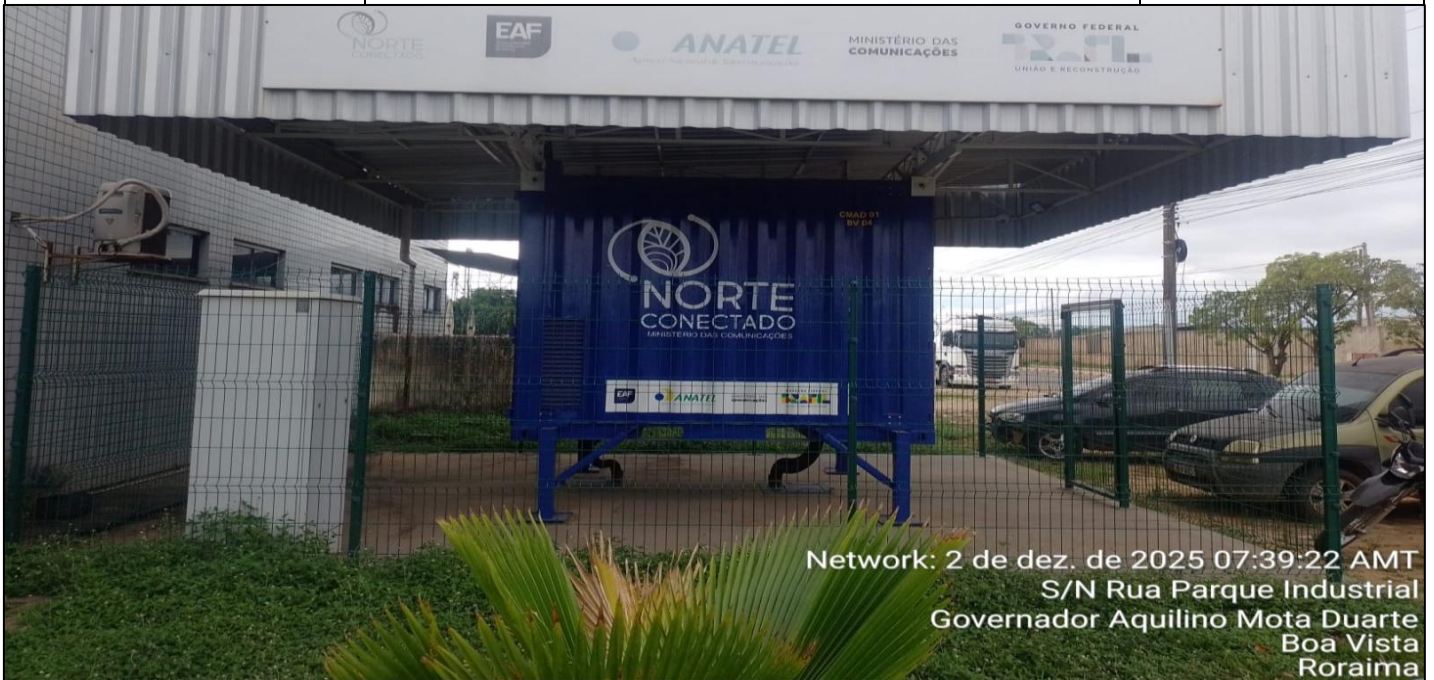
Área externa antes do processo de limpeza.
