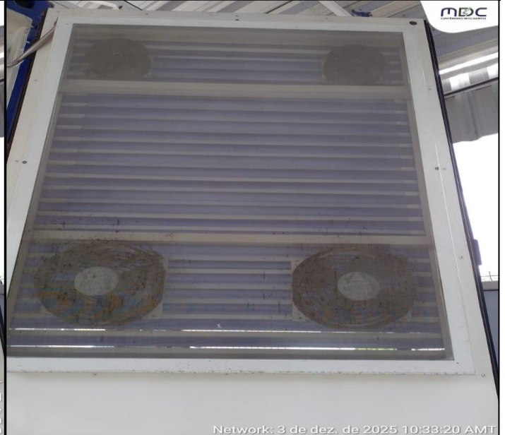
Ventiladores após o processo de limpeza , apresentando condições adequadas de operação e restabelecimento da eficiência do sistema de exaustão.
