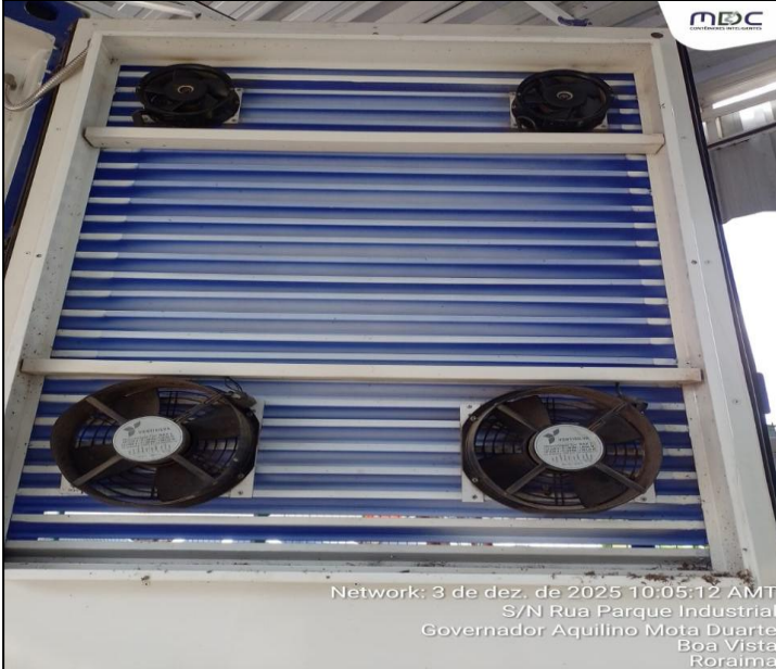
Ventiladores apresentando acúmulo significativo de sujeira antes do processo de limpeza.
